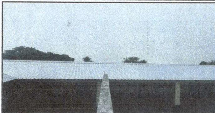
Foto 1: Sustitución de lámina, por lámina troquelada calibre 26
